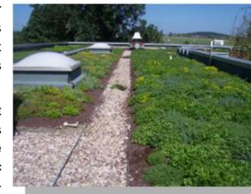
Ces techniques, plus adaptées pour de grands projets, ne peuvent être réalisées que sur de nouveaux projets ou des projets importants de réhabilitation. L'intérêt des végétalisations extensives (de faible épaisseur) apparaît limité. Par contre, les projets dits intensifs, avec des épaisseurs de sol dépassant 30 cm, apportent une réelle plus-value en matière de ruissellement, et aussi du point de vue du confort thermique d'été et de biodiversité.
